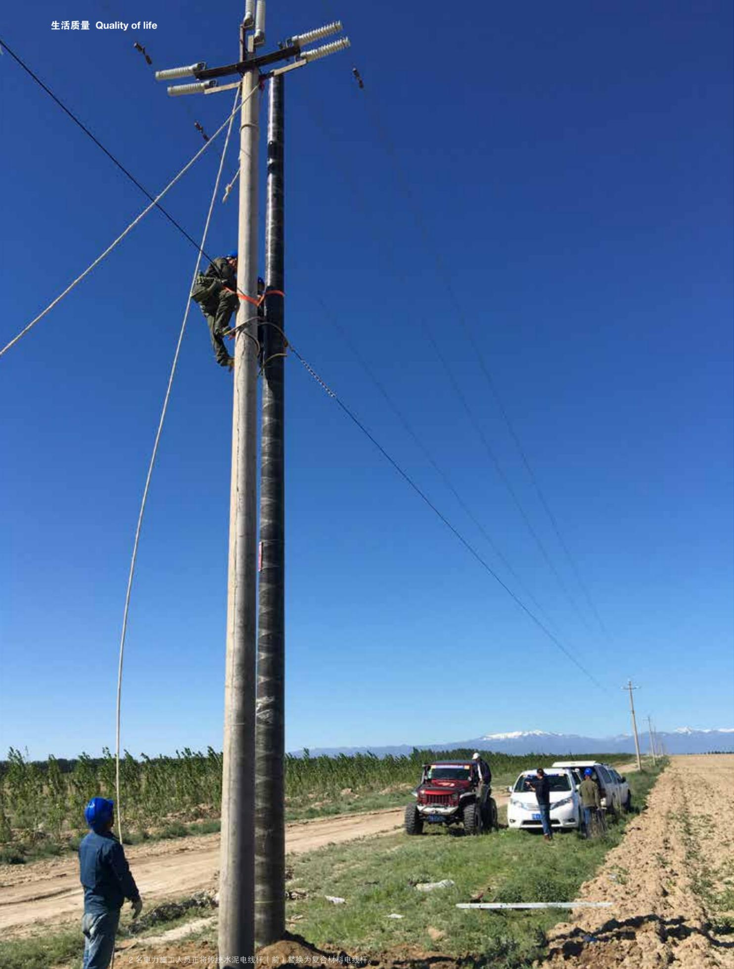
2名电力施工人员正将传统水泥电线杆（前）替换为复合材料电线杆。
