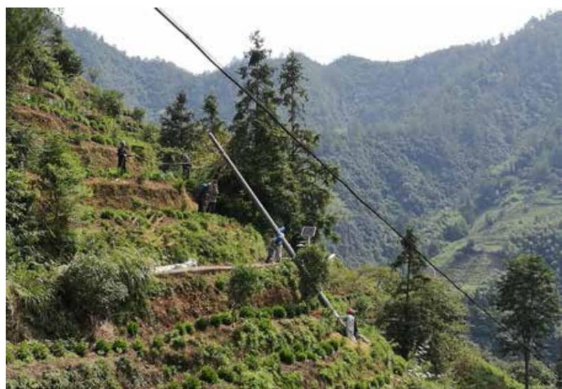
得益于复合材料电线杆，安徽黄山地区的电力抢修时间大幅缩短。图为几名电力施工人员正在运输新型电线杆。
